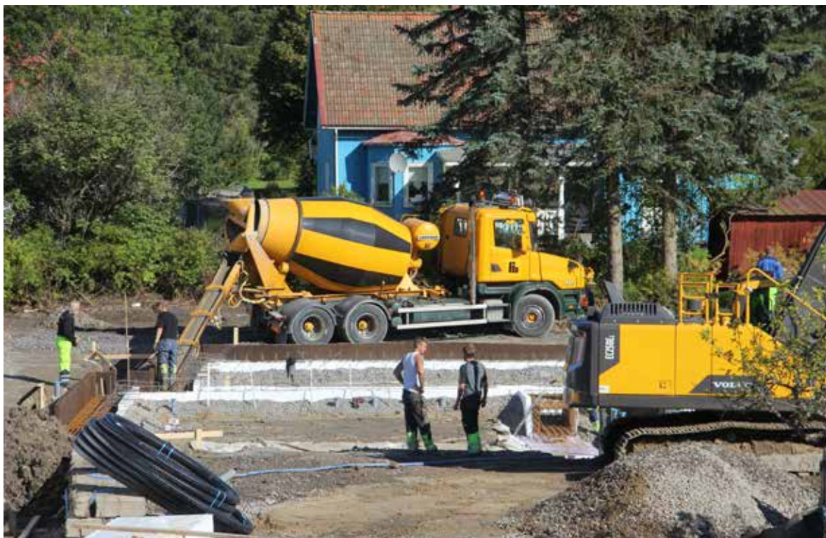
Gjutning påbörjad. Kvarteret Staren i Charlottenberg, 2015
